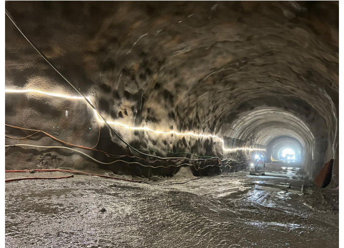
Implenia Suisse, ARGE Gotthard
